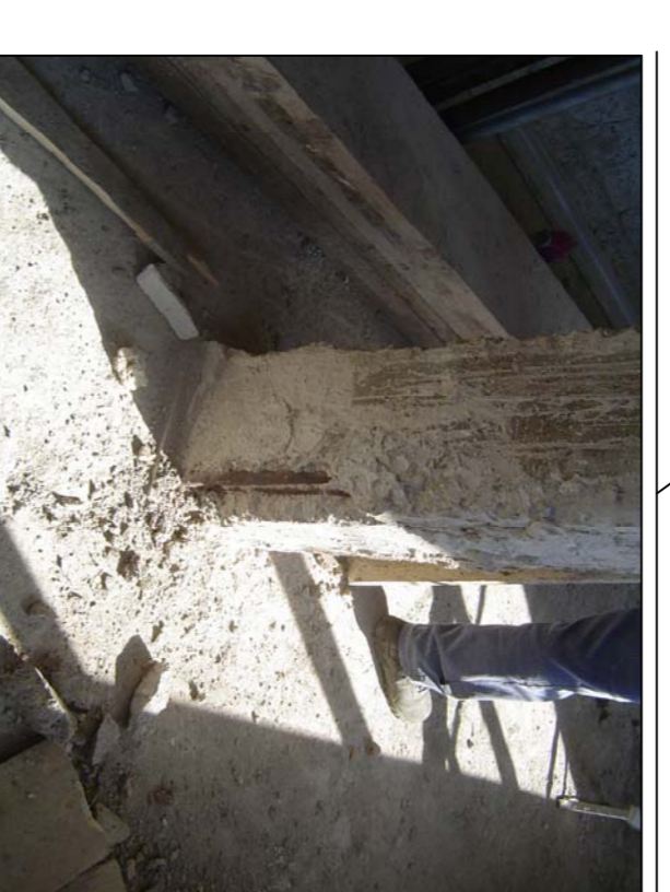
Piastri vari dove si evidenzia l'avanzato stato di corrosione delle armature principali e la mancanza di stalle
