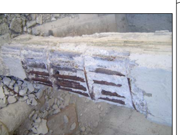
Piastri vari dove si evidenzia l'avanzato stato di corrosione delle armature principali e la mancanza di stalle
