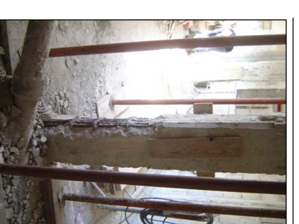
Piastri vari dove si evidenzia l'avanzato stato di corrosione delle armature principali e la mancanza di stalle
