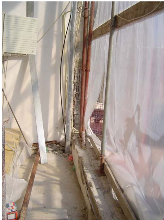
Rinvenimento di trave estradossata armata senza staffe
